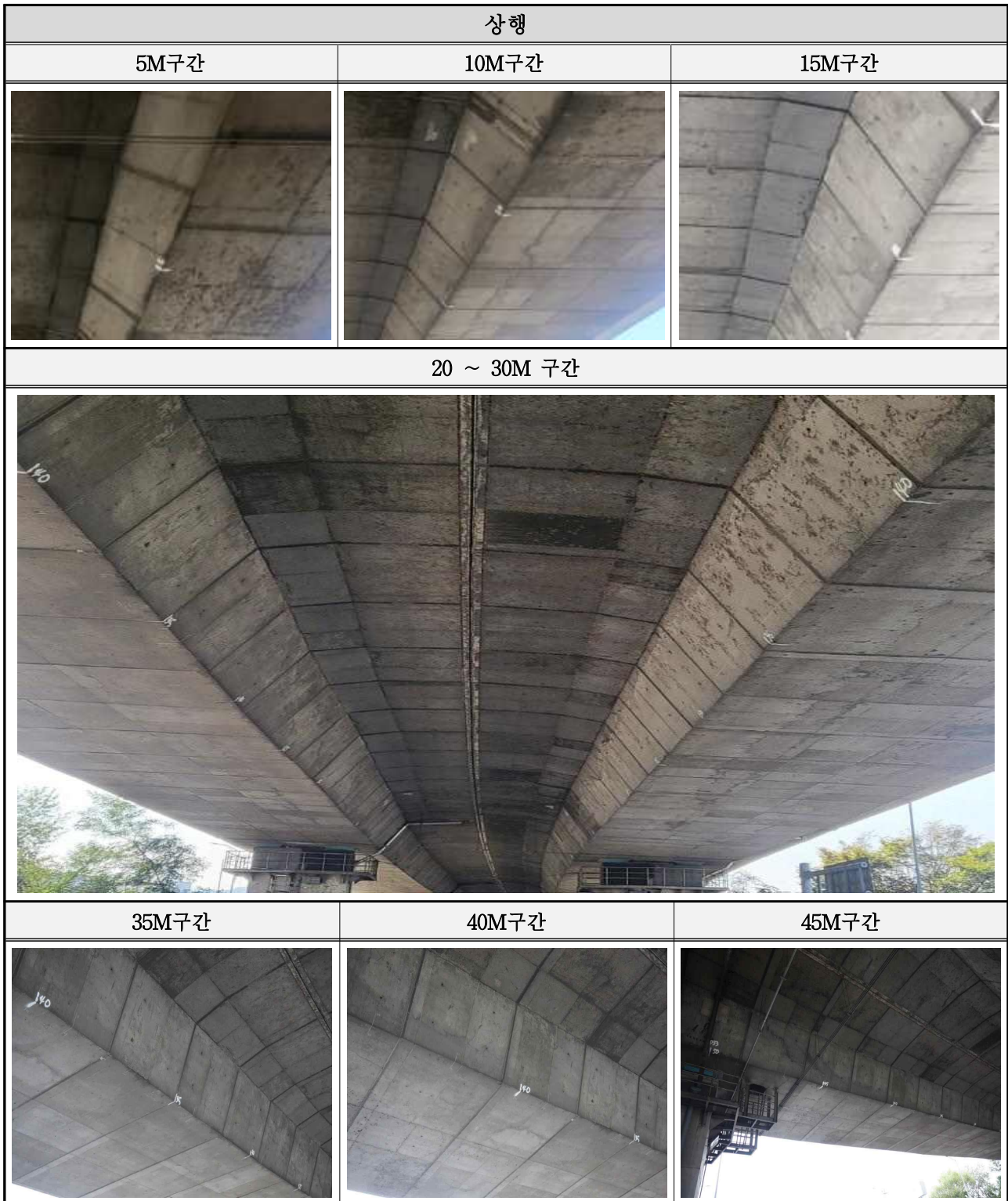
【사진 3.4.6】 거더외부(상행) 외관조사 관련사진
