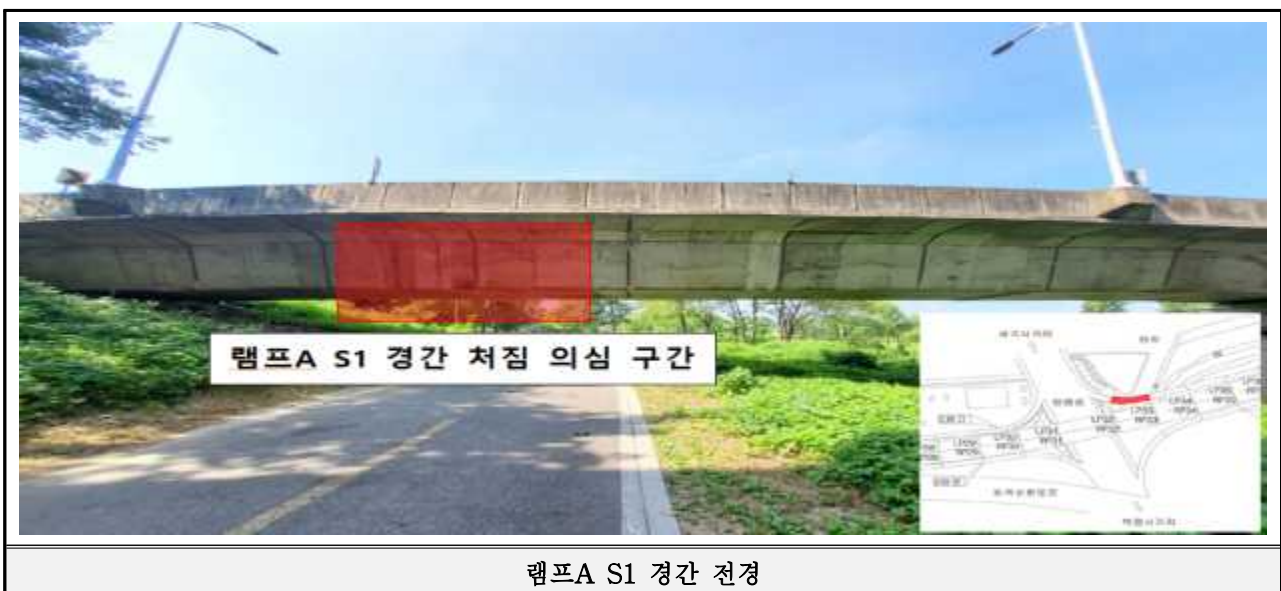
【사진 3.4.26】 램프A 처짐의심구간 S1 경간 전경
